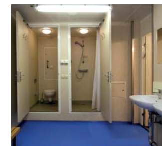
Przebiernia wraz z niezbędnym węzłem sanitarnym.
