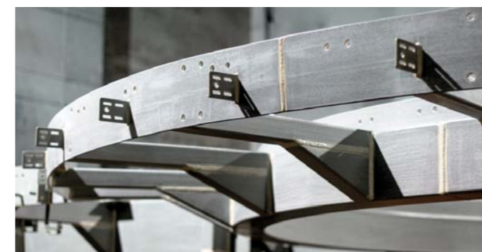
Wszystkie spoiny, konieczne krawędzie i elementy oraz miejsca trudno dostępne, przed malowaniem natryskowym, zostały przygotowane ręcznie (techniką „Stripe coating” – wyrabianie pędzlem) by zachować pełną penetrację farby w tych rejonach.
